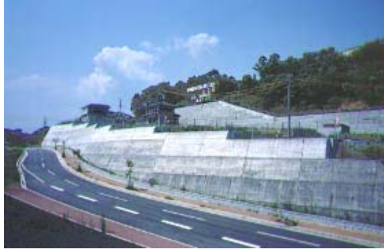
鹿島台宅地造成
